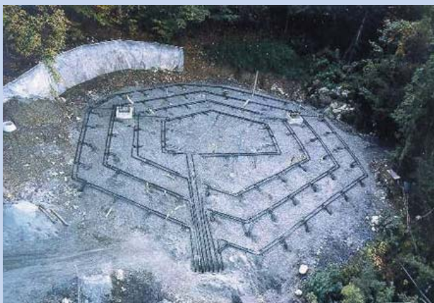
Verlegearbeiten in der Straßendecke (oben) und SERSO Erdsondenspeicher (unten)
