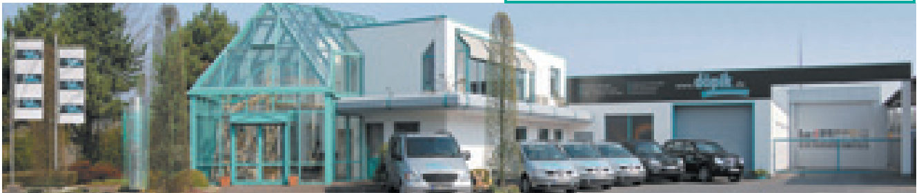
Besuchen Sie das döpik Energiezentrum
